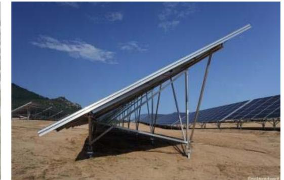
Photo 3 : Structures de support avec modules
