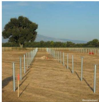
Photo 4 : Vis d'ancrage
