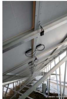
Photo 9 - Câblage sous les modules
